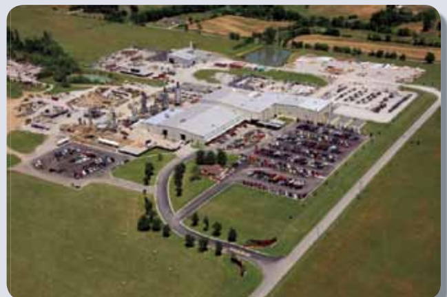
Центр тестирования оборудования ZEECO является крупнейшим в мире и первым, получившим сертификацию ISO
